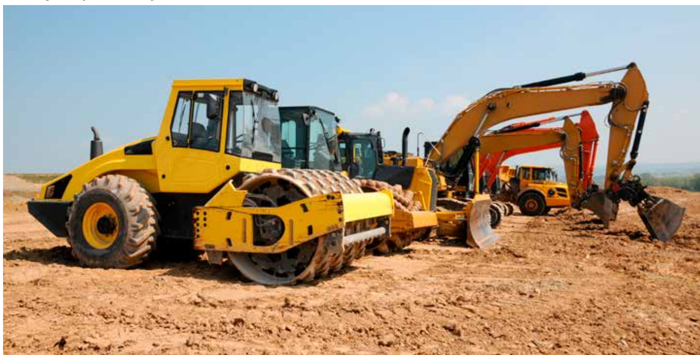
Abbildung 15: Beispiel für Sanierung von Altlasten
