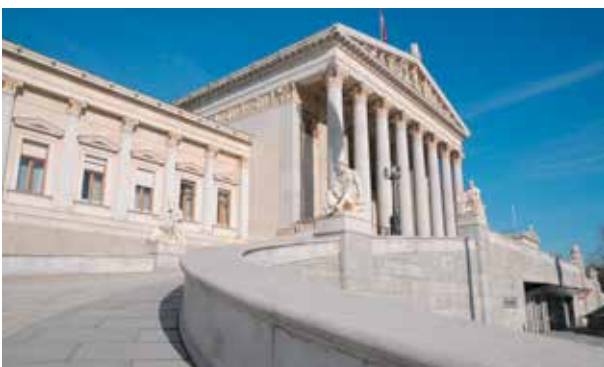
Historisches Parlamentsgebäude – Rampenbereich Buchwert Gebäude 33.892.131,91 Euro
