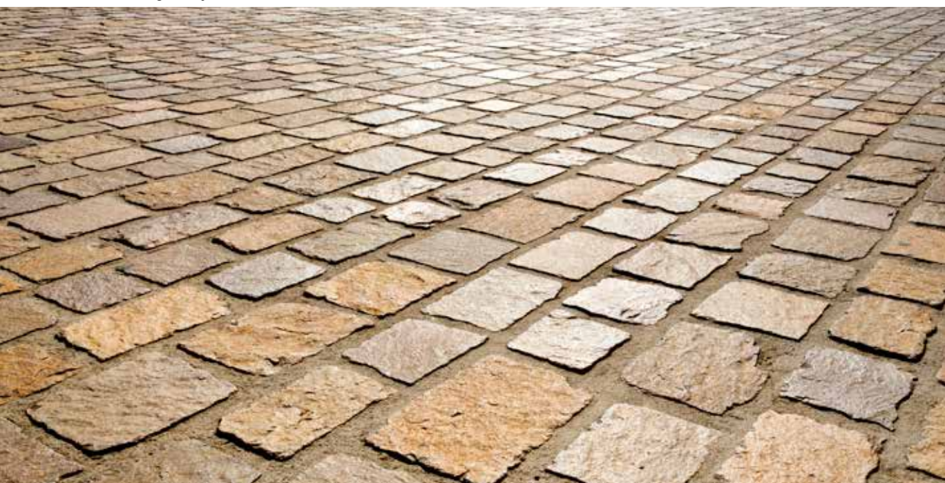
Abbildung 2: Beispiel für Pflasterstraße
