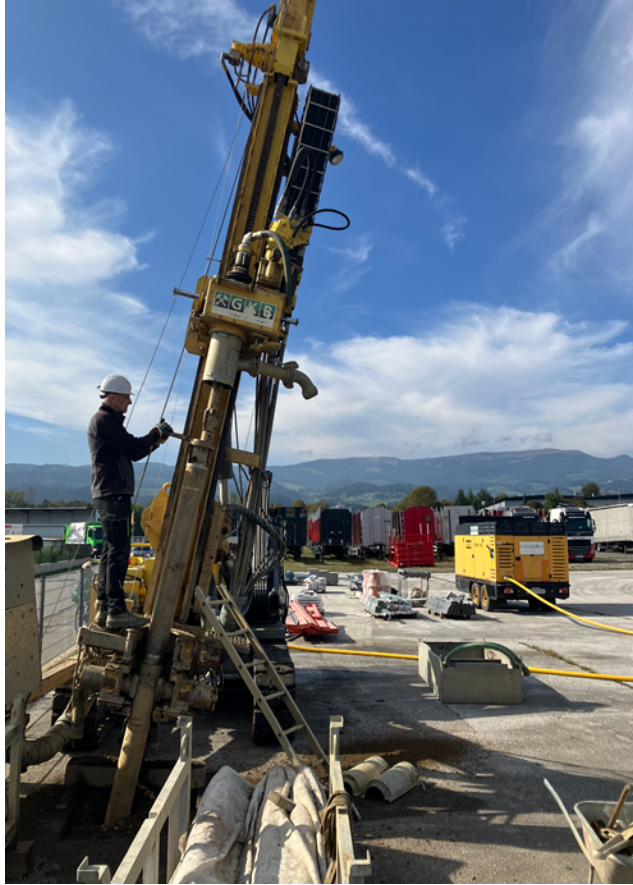
Abbildung 2 Bohrgerät, Verfüllarbeiten tagnaher Hohlräume mit stabilisierter Sandmischung der GKB-Bergbau GmbH
